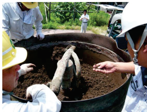
写真-2 攪拌時の触手確認
