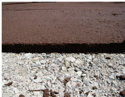
写真-4 路盤状況
