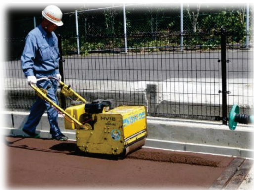
写真-3 敷均し後の転圧
