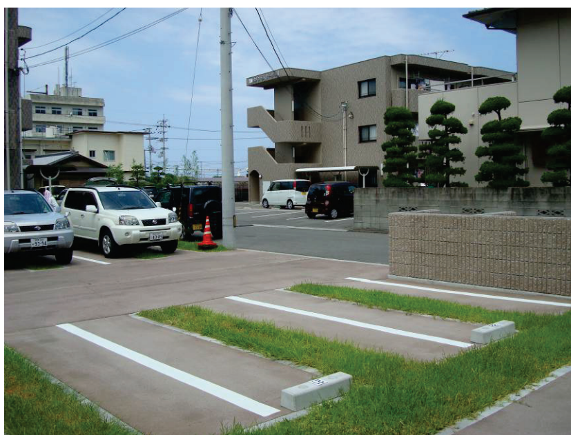
写真－7 樹皮舗装の本施工現場
