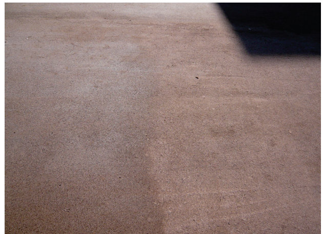
写真-6 転圧締め固め後の路面状態
