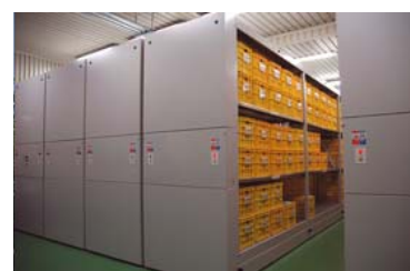
写真-1 第 1 冷凍庫室
