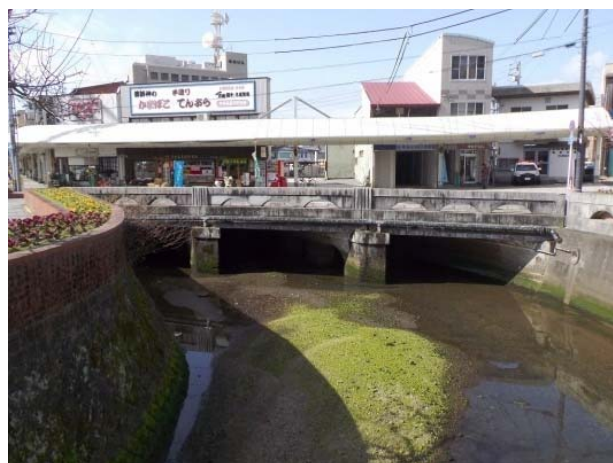
写真－1 調査対象のS橋
