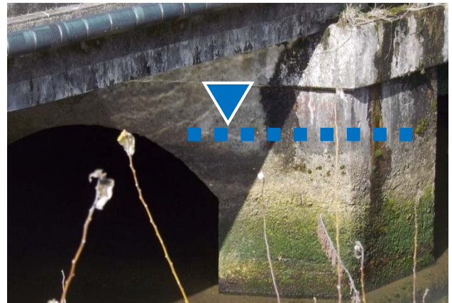
写真-2 橋脚満潮時の水位による境界線
