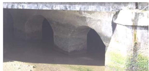
写真-3 壁式アーチ構造の橋脚
