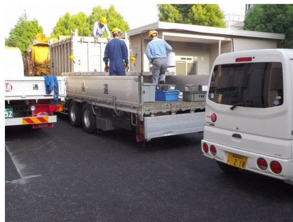
写真 14 高濃度PCB廃棄物の搬出状況
