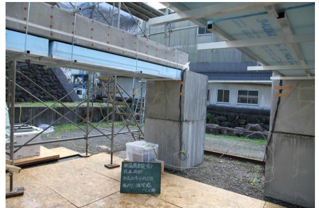
図4 電食実験の外観
